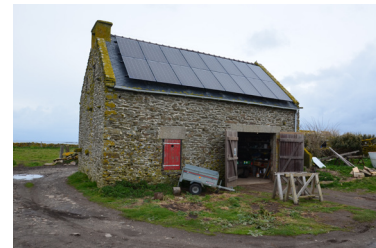
Les panneaux solaires et l'éolienne apportent l'électricité nécessaire.
